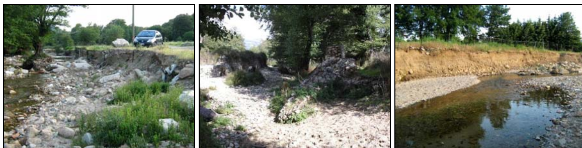
Figura 2: Sponde in erosione - Gabbionata danneggiata alla confluenza con il canale urbano
