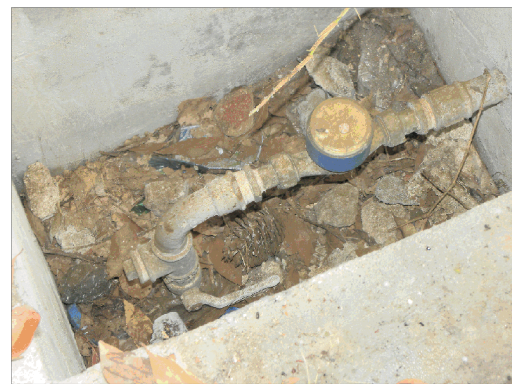
PARTICOLARE POZZETTO CONTATORE INGRESSO ACQUA
