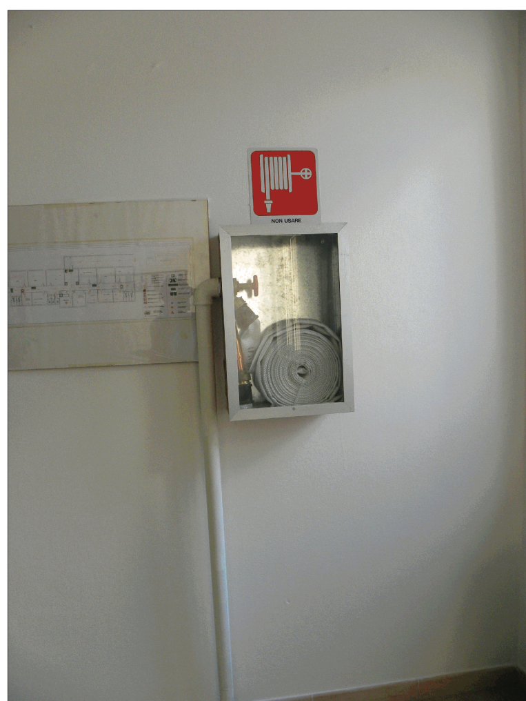
PARTICOLARE IDRANTE PIANO PRIMO
