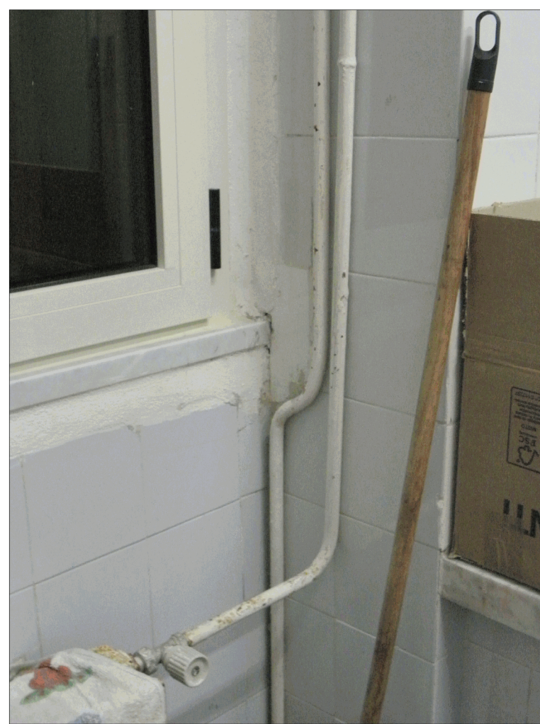
PARTICOLARE DERIVAZIONE E ATTACCO TERMOSIFONE
