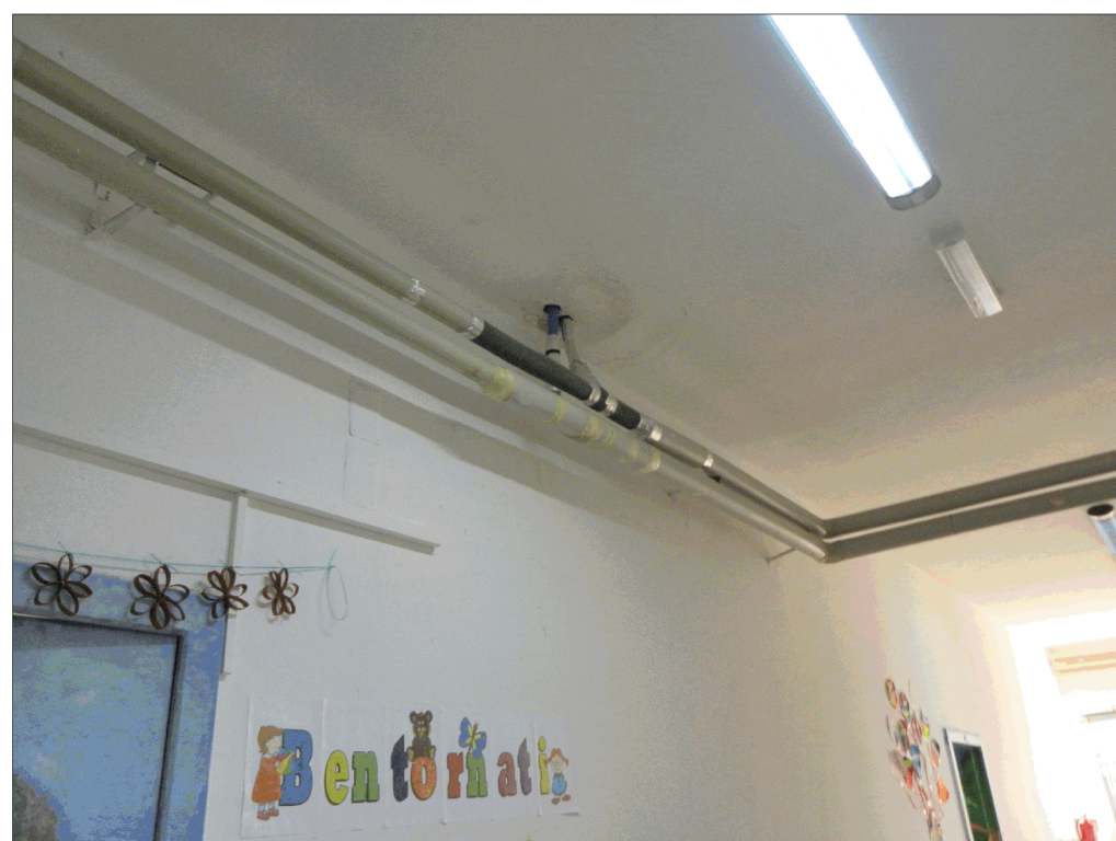
PARTICOLARE DELLA DORSALE DI DISTRIBUZIONE IMPIANTO DI RISCALDAMENTO
