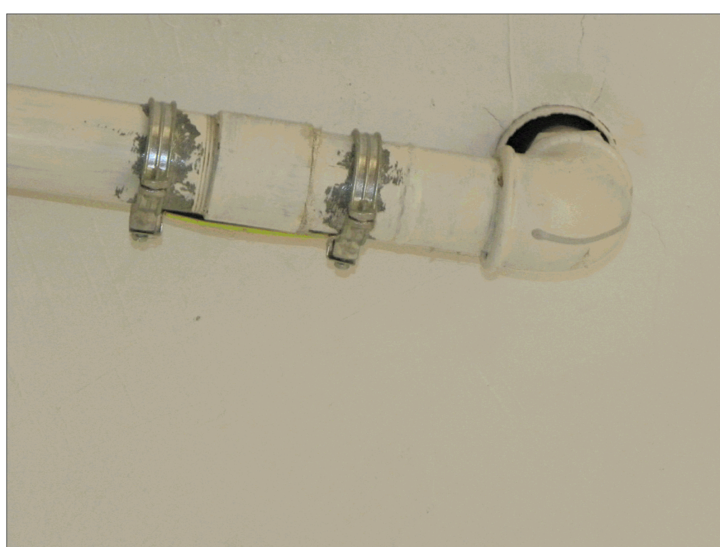
PARTICOLARE ATTRAVERSAM ENTO DEL SOLAIO DELLA RETE IDRANTI PER IL PIANO PRIMO
