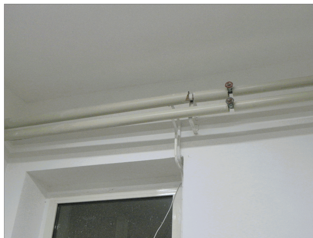
PARTICOLARE DERIVAZIONE DALLA DORSALE PER ATTACCO TERMOSIFONE
