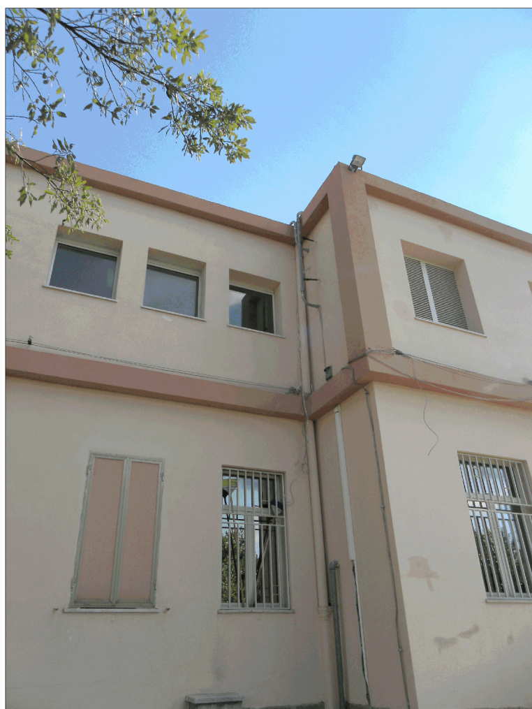
PARTICOLARE INFISSO DA RIPRISTINARE E INGRESSO COLONNA IMPIANTO IDRANTI
