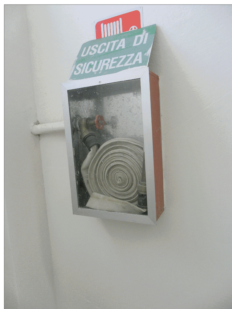
PARTICOLARE IDRANTE PIANO RIALZATO
