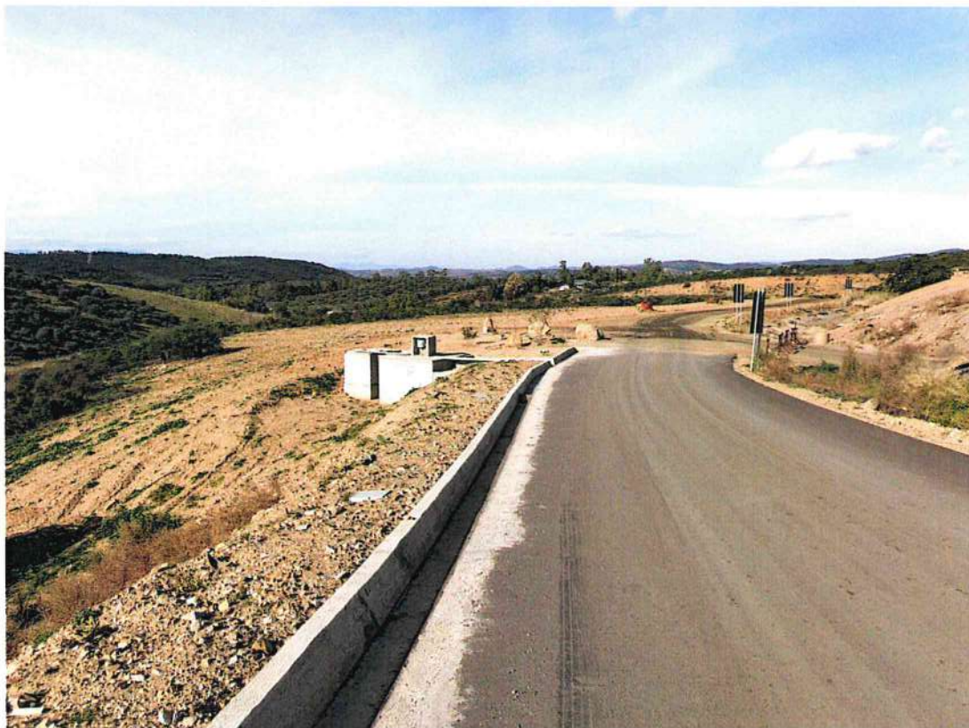
Figura 10: Canala di raccolta acque meteoriche
