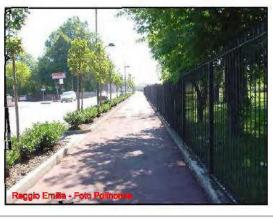
Esempio di pista ciclabile di tipo separata dalla sede stradale. Nel presente progetto accade ogni qual volta, fuori dai centri abitati ci sia lo spazio sufficiente per allontanarci dalla sede stradale attuale. Accade spesso che la pista segua l'orografia del terreno e si crea fra le due pista una scarpata verde. Il dislivello non è mai superiore a 80 cm.
