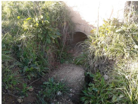
Nello specifico: le cunette e gli attraversamenti esistenti nel tracciato stradale ormai intasati, per l'effetto erosivo dell'acqua, da materiali terrosi, ed in parte anche dalla vegetazione che vi si è sviluppata, verranno puliti e ripristinati.
