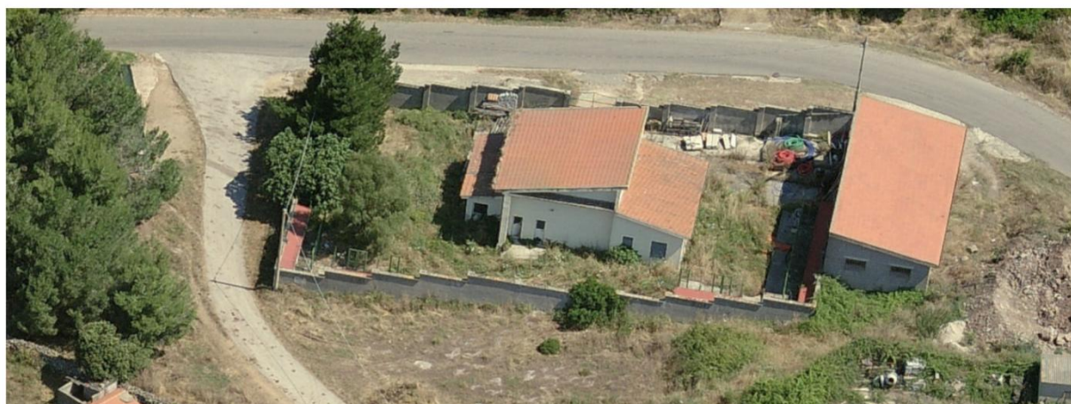
Figura 18: esposizione dei tetti dell'ex-canile.
