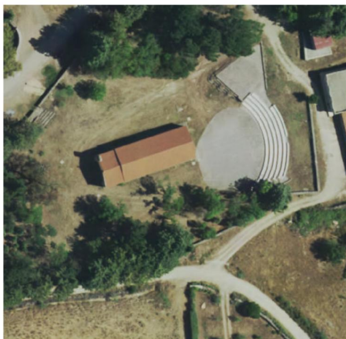
Figura 15 – Esposizione dei tetti della Chiesa dell'Angelo.
