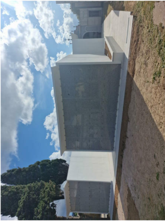
Immagine dei blocchi realizzati con l'intervento appena concluso. Il presente progetto di completamento rispetterà la stessa tipologia di materiali e componenti in tutto e per tutto similari.
