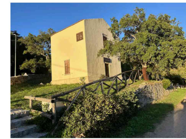
Recupero della vecchia cantoniera ex ferrovia a scartamento ridotto
