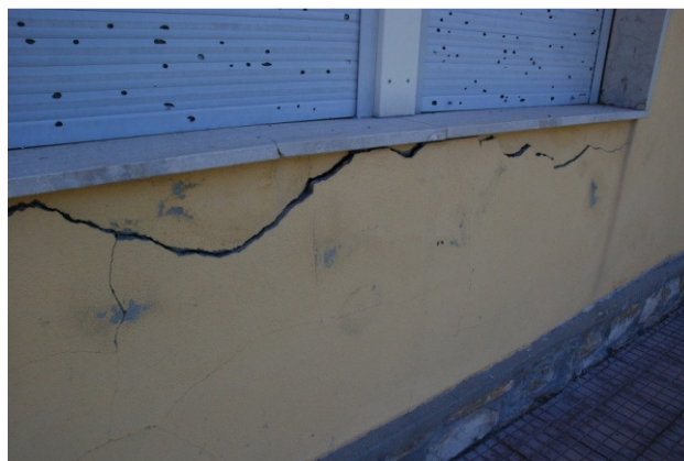
Figure 3 e 4 - Degrado dei sottofinestra ala Sud-Ovest e particolare dell'intonaco ammalorato in distacco
