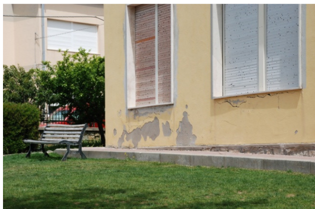
Figure 3 e 4 - Degrado dei sottofinestra ala Sud-Ovest e particolare dell'intonaco ammalorato in distacco
