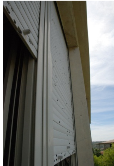
Figura 8, 9 e 10 - Degrado degli infissi esterni e degli avvolgibili
