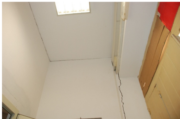
Figura 5 e 6 - Lesioni della bussola d'ingresso allo stabile e balaustra sottodimensionata nell'atrio d'ingresso
