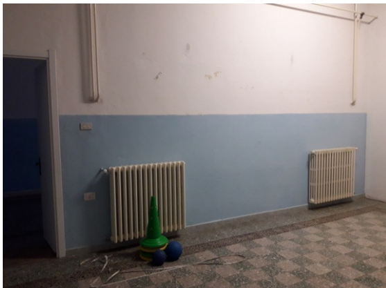
Figura 11 e 12 Assenza di controllo termostatico nell'aula "ex attività ludiche" e termostato demolito nell'aula "5"
