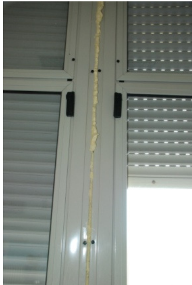
Figura 8, 9 e 10 - Degrado degli infissi esterni e degli avvolgibili
