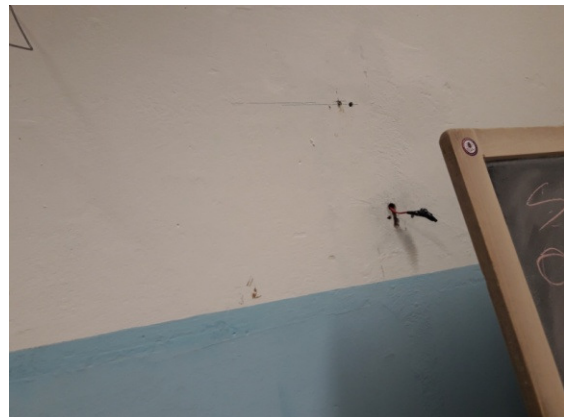
Figura 11 e 12 Assenza di controllo termostatico nell'aula "ex attività ludiche" e termostato demolito nell'aula "5"
