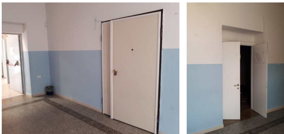
Figura 13 e 14 - Tipologia delle porte interne in demolizione
